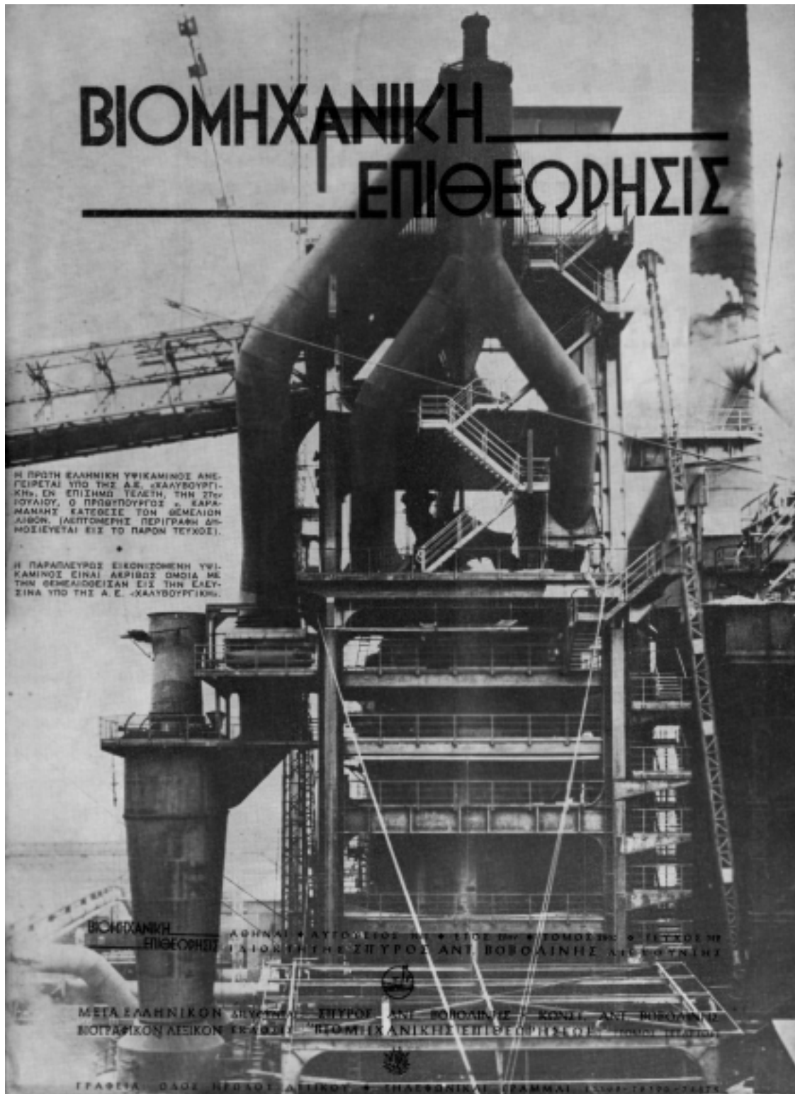
Εξώφυλλο της Βιομηχανικής Επιθεώρησης, αφιερωμένο στη θεμελίωση της πρώτης υφικαμίνου της Χαλυβουργικής (1961)
